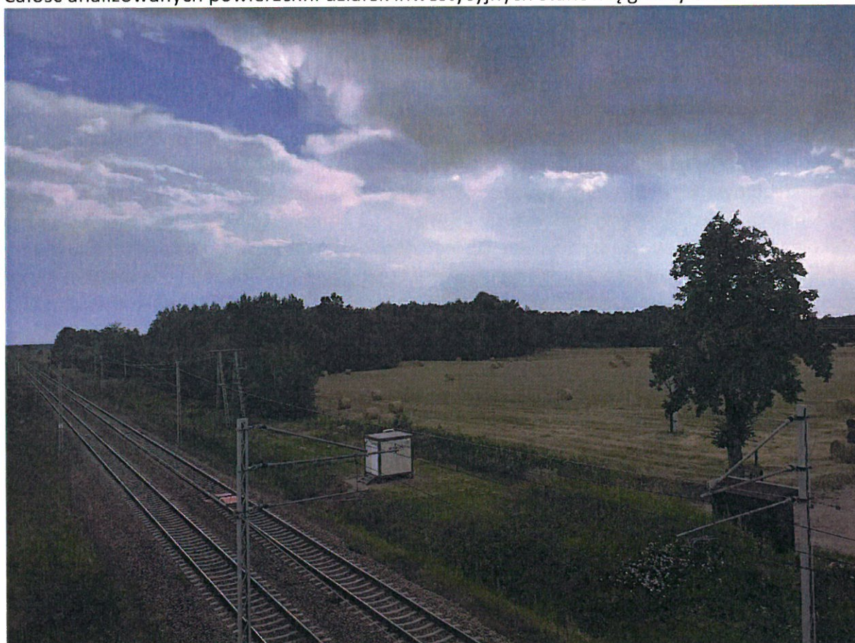
Rys. 12 Widok ogólny – z wiaduktu kolejowego (pole i fragment zadrzewienia).
