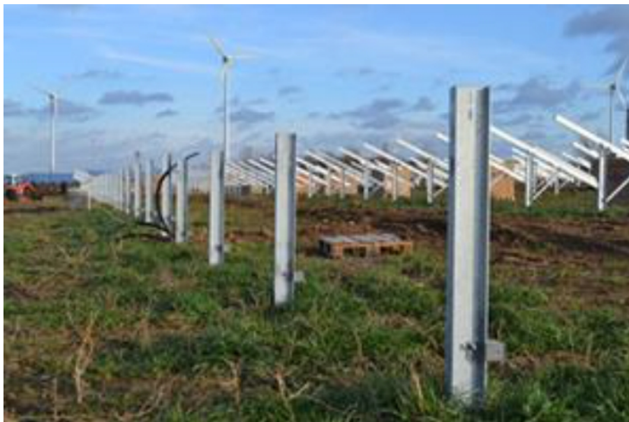
Zdjęcie 2 Profile metalowe: podstawowy element konstrukcji.
