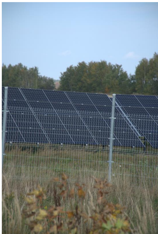
Rys. 9. Przykładowe ogrodzenie inwestycji (źródło: archiwum własne)
