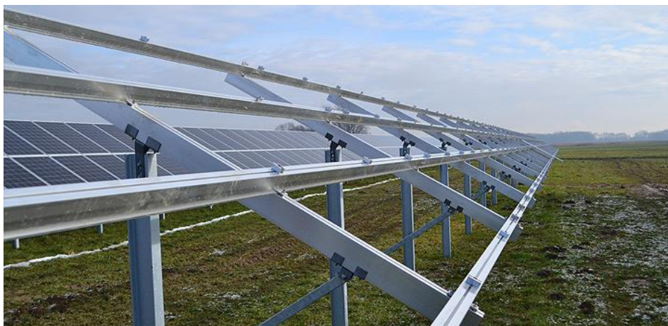
Rys.3. Przykładowe konstrukcje wsporcze ( https://www.planergia.pl/post/konstrukcje-wsporcze-dla-paneli-fotowoltaicznych-2519 )
