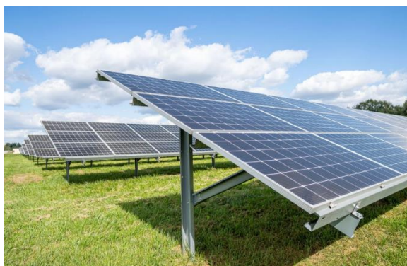
Rys. 20. Przedstawienie przykładowych konstrukcji pod panele fotowoltaiczne ( https://budujemydom.pl/ )
